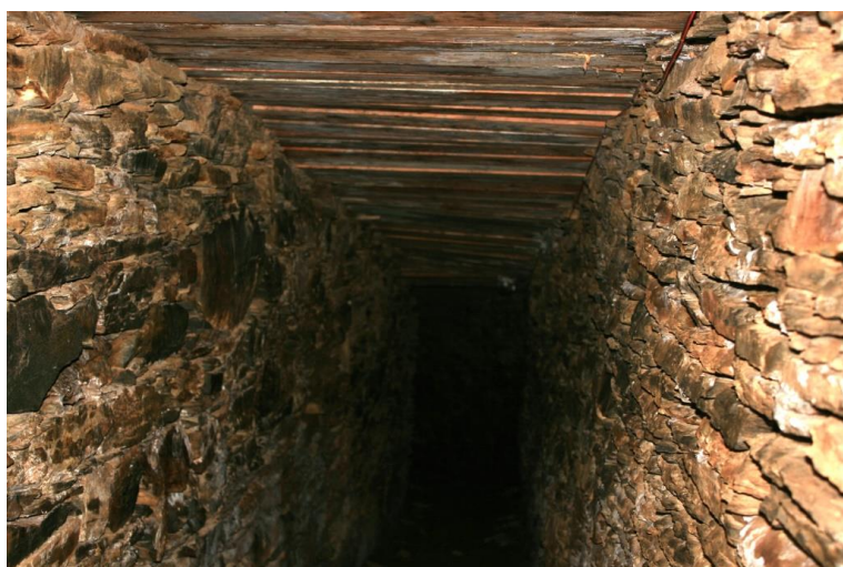
interno del camminamento coperto, perfettamente recuperato (serve una fonte di illuminazione)
